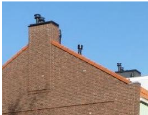
Figuur 23: Gevelpannen voor toegang tot dakbeschoot.
