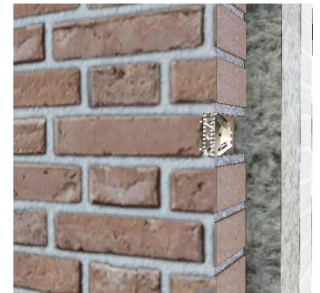
Figuur 11: Stootvoegroosters, zoals dit bijenbekje, zijn makkelijk te verwijderen.
