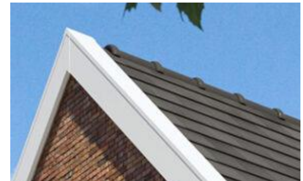
Figuur 24: Windveer voor toegang tot dakbeschoot.
