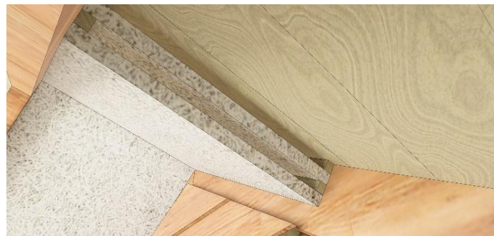
Figuur 30: Dakbeschotkasten zijn één- of meerlaagse aan dakbeschot evenwijdige platen waar vleermuizen tussen kunnen kruipen.
