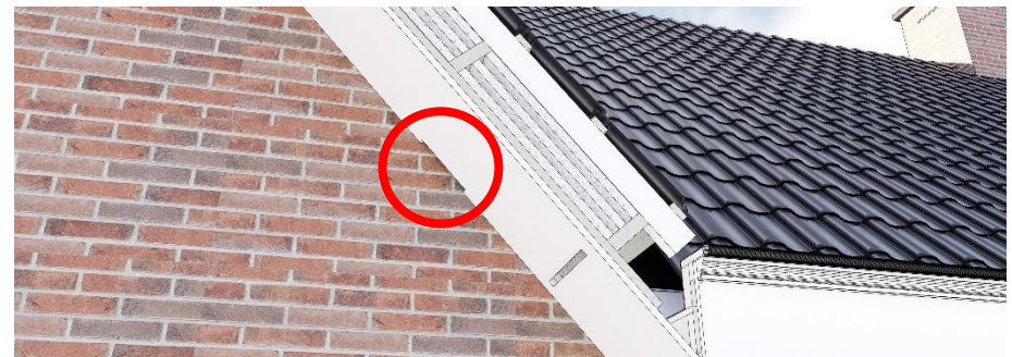
Figuur 25: Bij verblijfplaatsen in de dakrand is het extra belangrijk om kastconstipatie te voorkomen. De spleet haaks op de muur is voor de afvoer van de ontlasting. De spleet langs de muur (in rode cirkel) is de entree voor vleermuizen.
